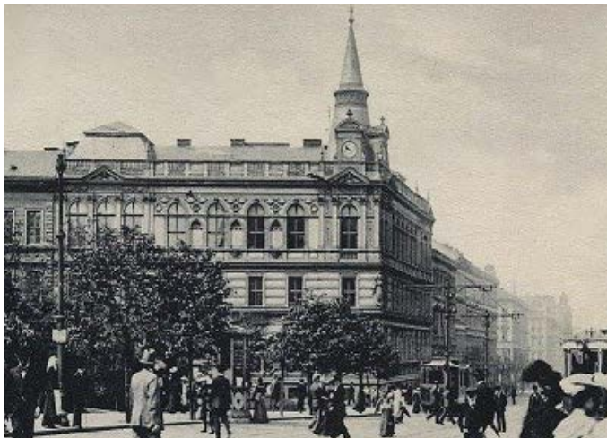
Budova radnice před rekonstrukcí z roku 1928, pohlednice (M.Polák)
