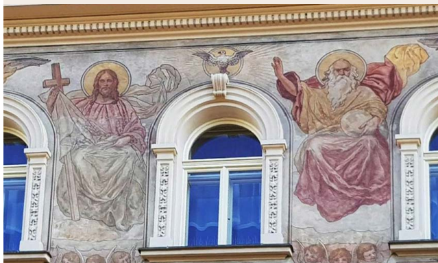
Vyobrazení Nejsvětější Trojice na fasádě domu U Prasátků v blízkosti podskalského kostela
