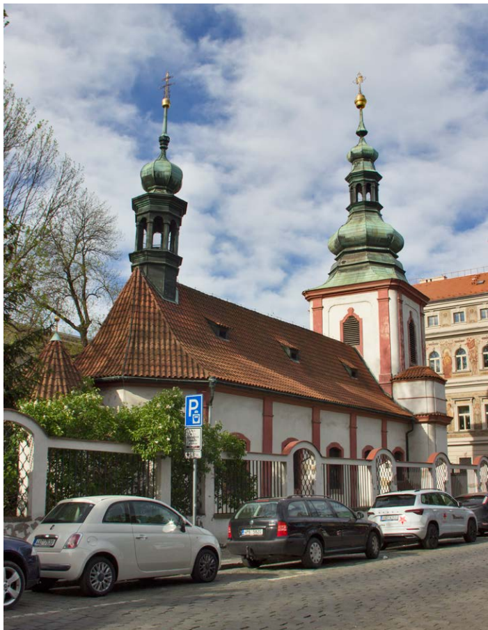
Pohled na kostel od severovýchodu, z Trojické ulice
