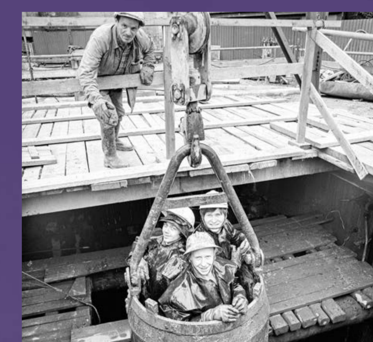
Průběh stavby metra
