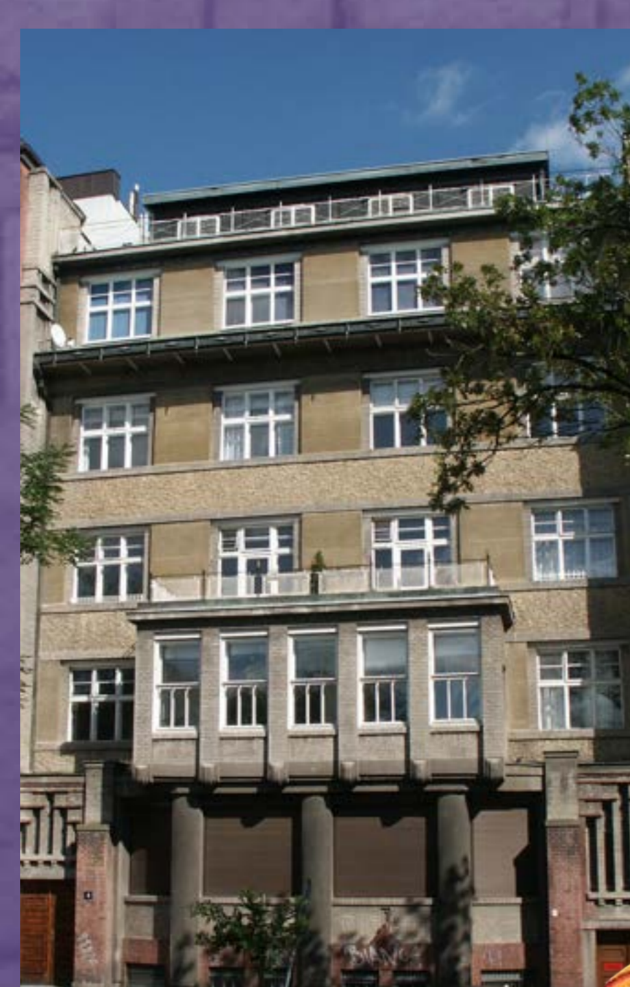
Pro nakladatele Jana Laichtera navrhl mezi lety 1908–1909 arch. Jan Kotěra dům s fasádou zdobenou jen desěny v bílém režném zdvu v Chopinově ulici čp. 1543/4
