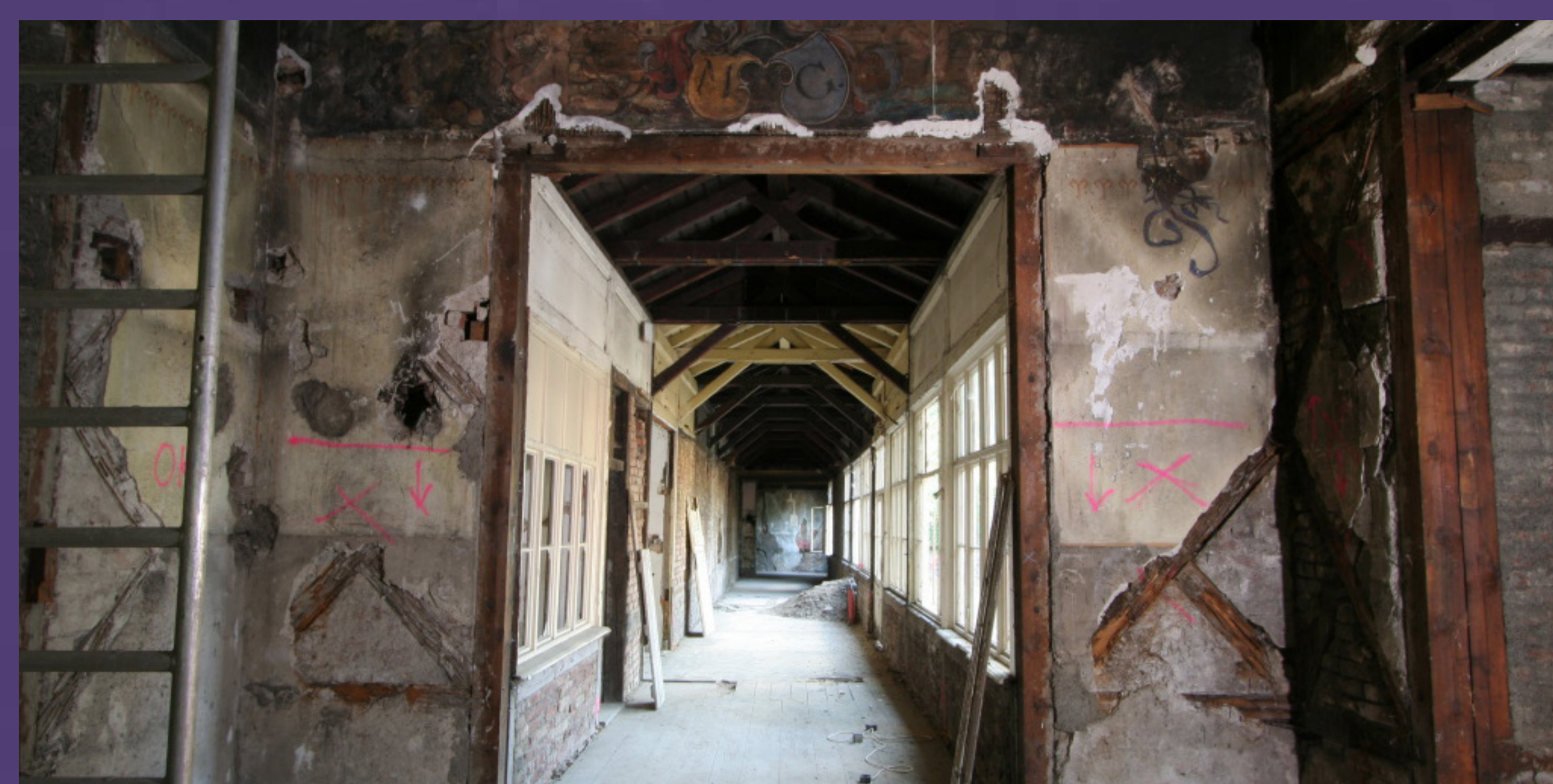
Pavilon v Havlíčkových sadech před rekonstrukcí
