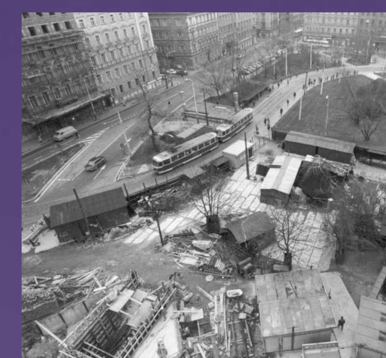
Stavba metra Náměstí Míru
