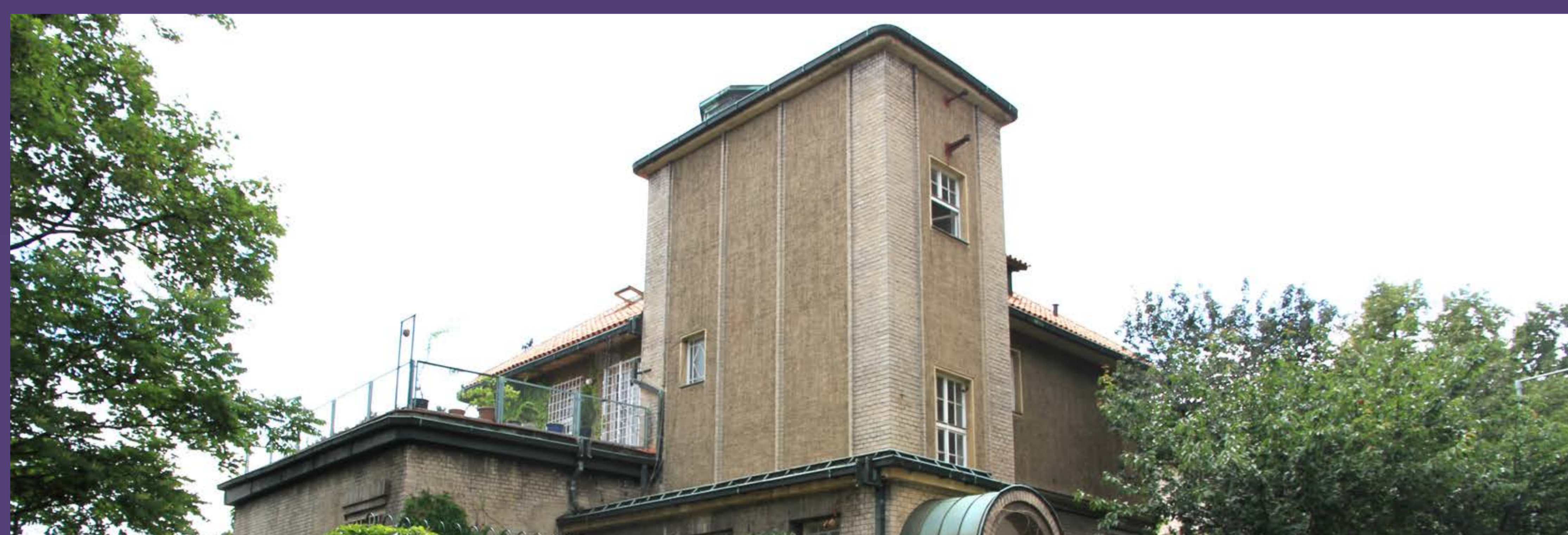
Vila, kterou si sám v roce 1908 navrhl architekt Jan Kořera v Hradešinské ulici čp. 1542/6, patří k nejfotografovanějším v Praze. Po Kořerově smrti ji dědicové r. 1927 prodali JUDr. Koeserovi. V roce 1939 ji získali současní vlastníci. R. 1948 jim byla vila odebrána, rozdělena na několik bytů a po roce 1989 opět v restituci navrácena
