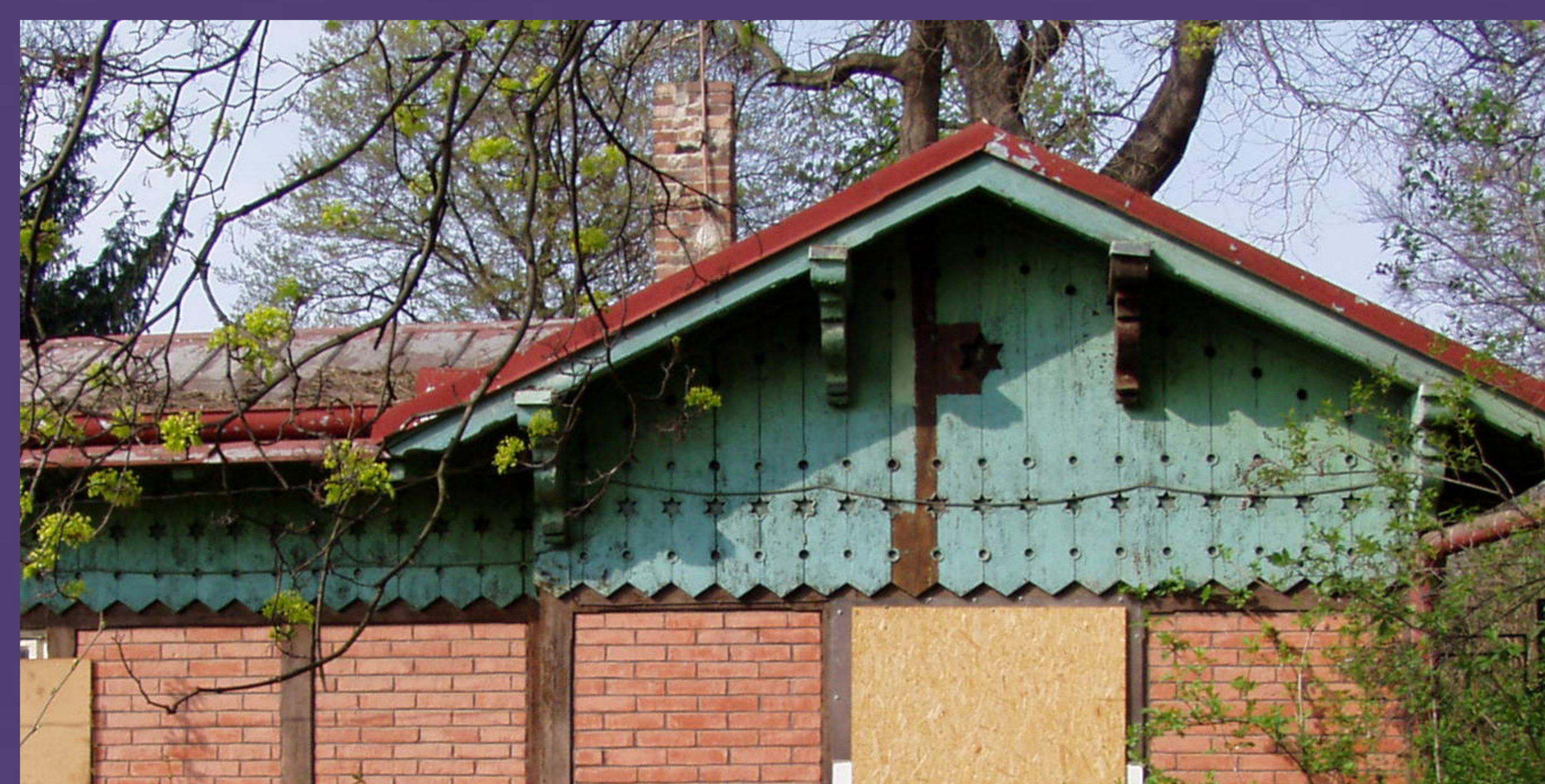
Rekonstrukce Pavilonu v Havlíčkových sadech
