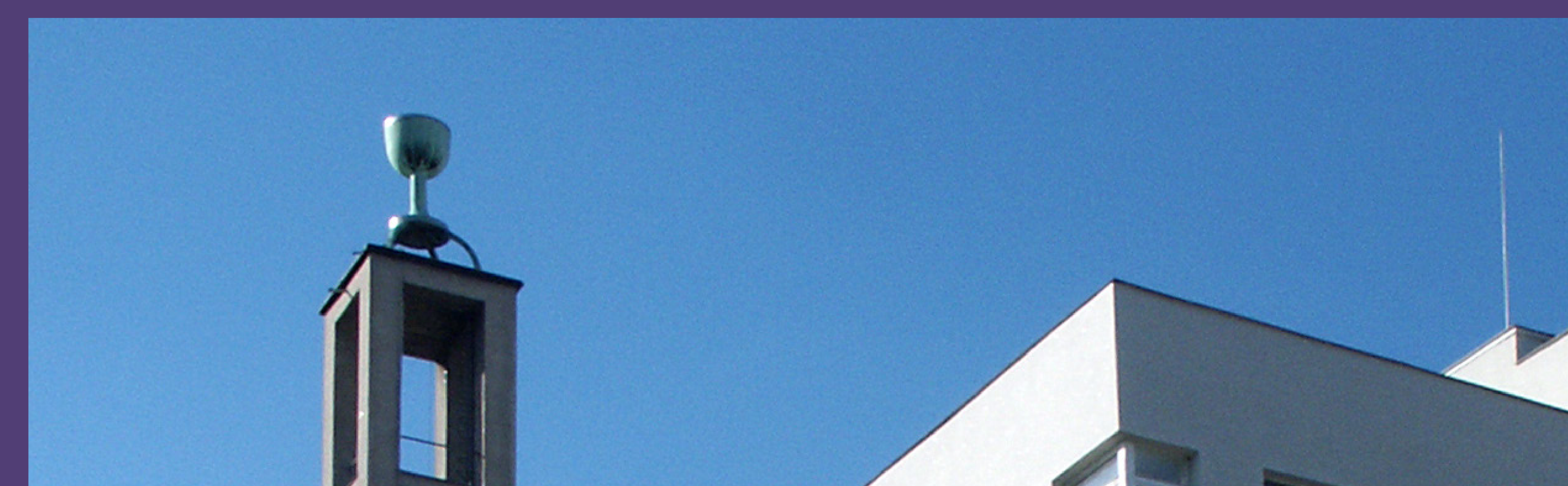
Husův sbor na Vinohradech v Dykové ulici čp. 51/1, s věží vysokou 34,5 m, navrhl architekt Pavel Janák (1882–1956). Byl vysvěcen r. 1933. Původně divadelní sál byl r. 1938 podle projektu Jiřího Jakuba (1905–1971) proměněn na kolumbárium, ve své době jedno z největších v Evropě
