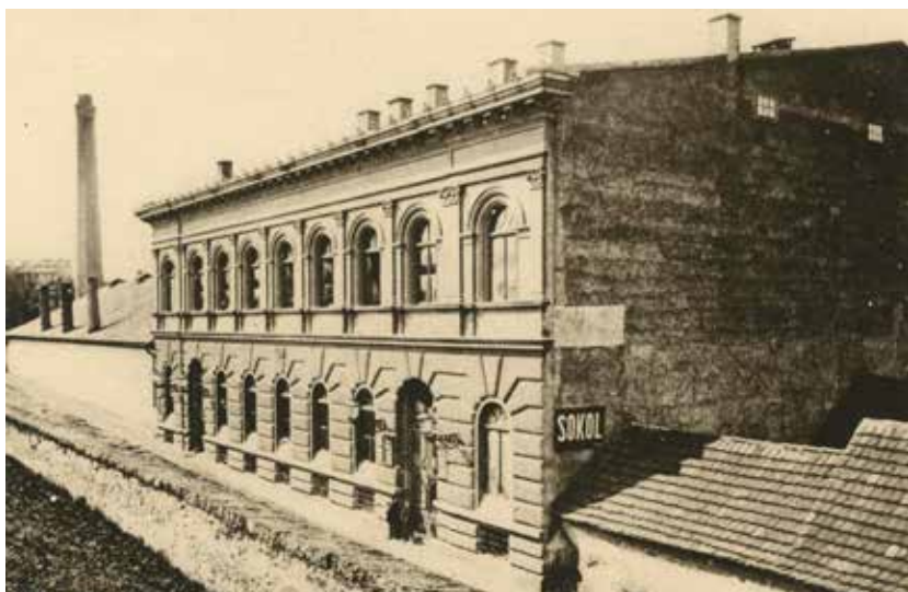
BUDOVA SOKOLA PRAŽSKÉHO
