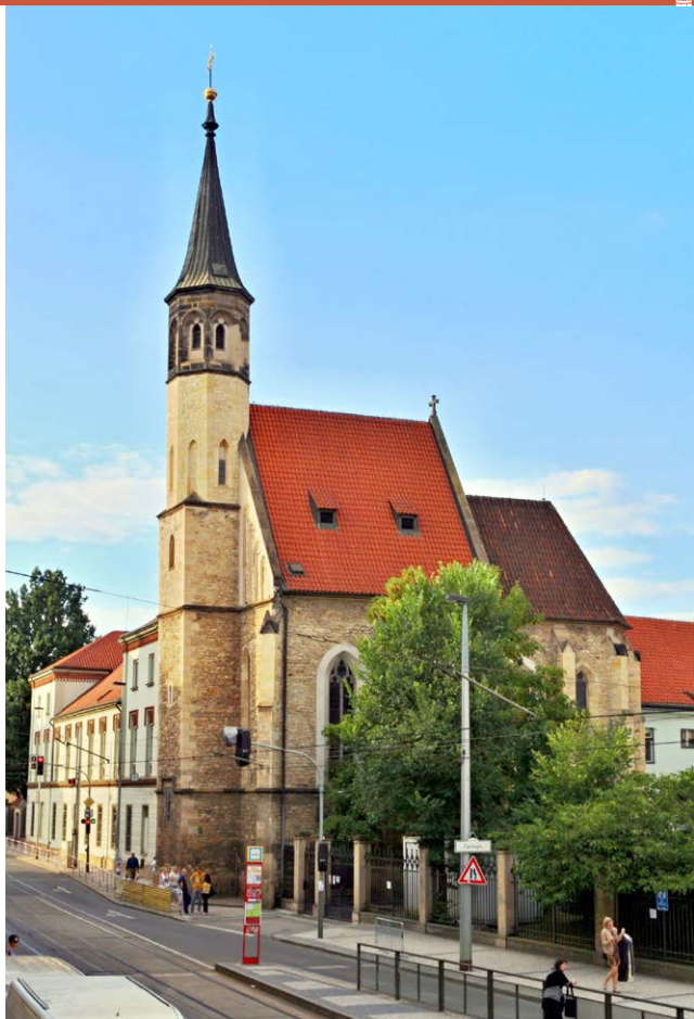
Celkový pohled na kostel od jihu z ulice Na Slupi (foto: Vít Václav Vít)
