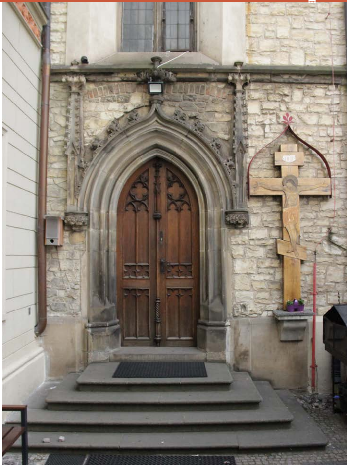
Severní novogotický vstupní portál
