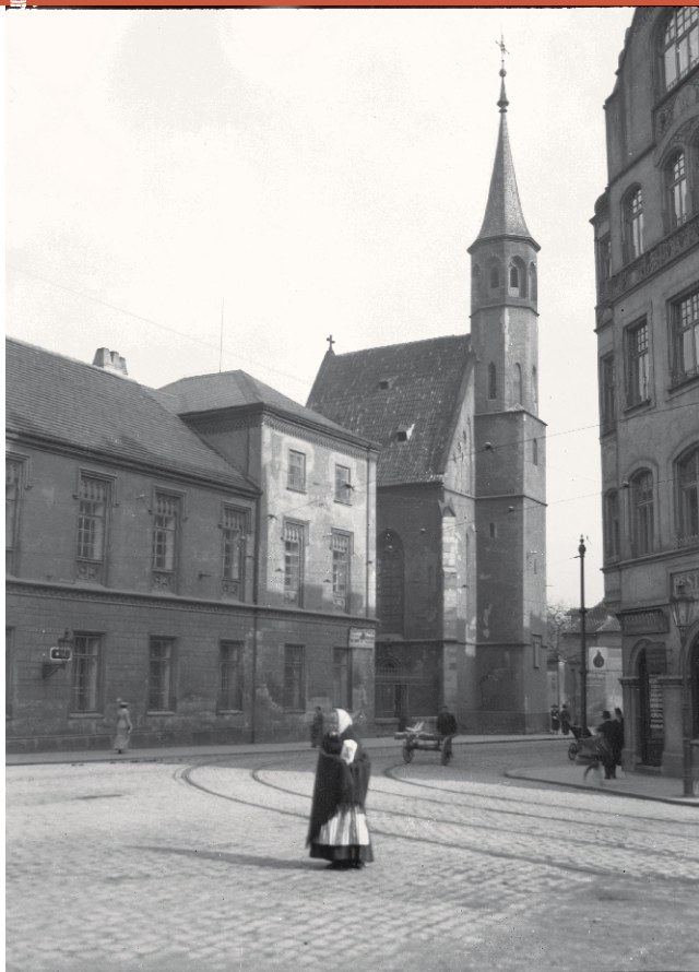
Kostel P. Marie Na Trávničku, foto neznámého autora (1914). Ze sbírky Muzea hl. m. Prahy. Pohled na kostel z křižovatky ulic Na Slupi a Svobodova se do dnešní doby příliš nezměnil.
