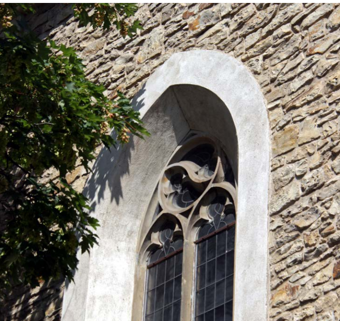
Detail novogotické kružby východního okna v jižní stěně lodi
